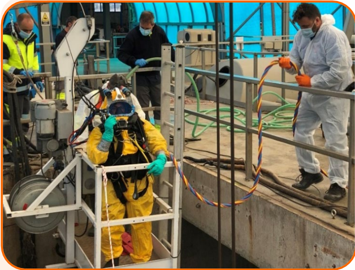
Trabajos en aguas con riesgo biológico
