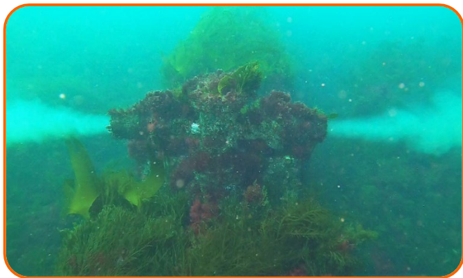
Inspección y mantenimiento de emisarios e inmisarios.
